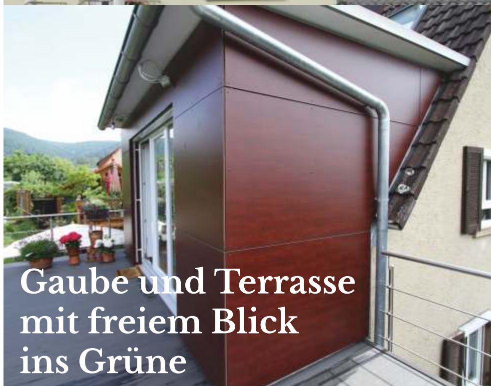
Gaubenausbau mit Bodenverlängerung
